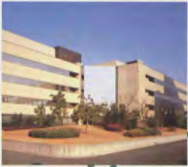
ITJ 東京通信センター ITJ Tokyo Telecom Center
