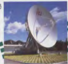
ITJ 上山口衛星通信局 ITJ Kamiyamaguchi Satellite Earth Station
