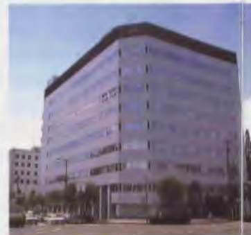
ITJ 大阪通信センター ITJ Osaka Telecom Center
